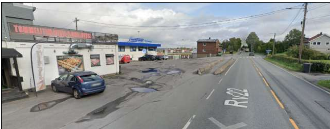
Figur 2: Kryssområdet med Sulfatveien med gatekjøkken og idrettshuset.
