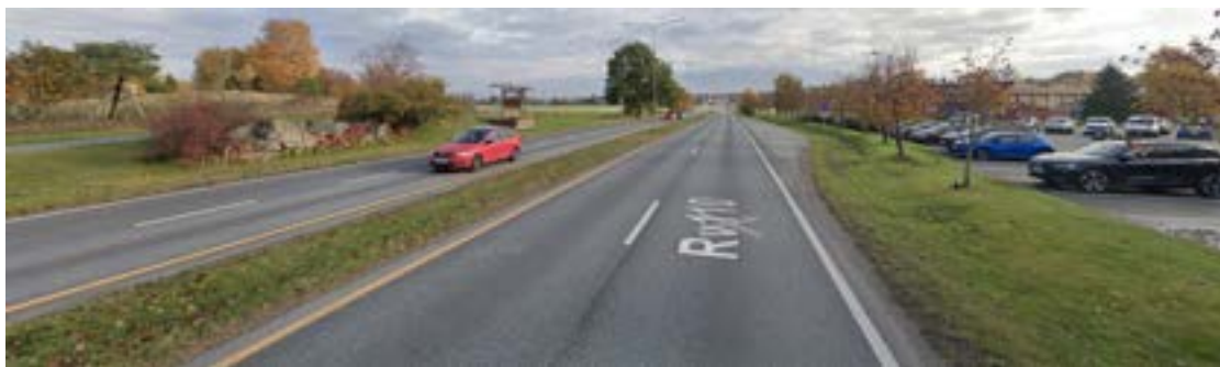
Eksisterende situasjon langs rv.110
