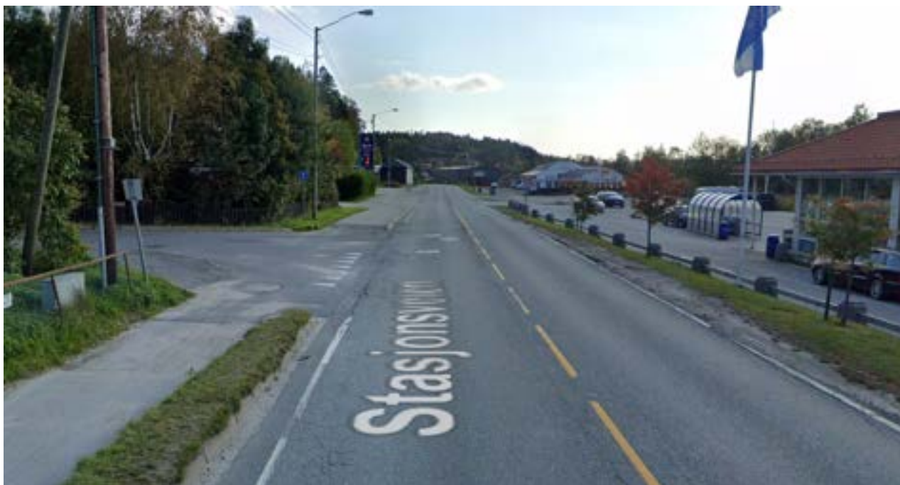
Eksisterende situasjon langs fv.118
