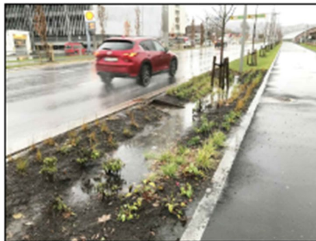
Eksempel på regnbed utført av Statens Vegvesen i Bjørnstjerne Bjørnsons gate i Drammen.
