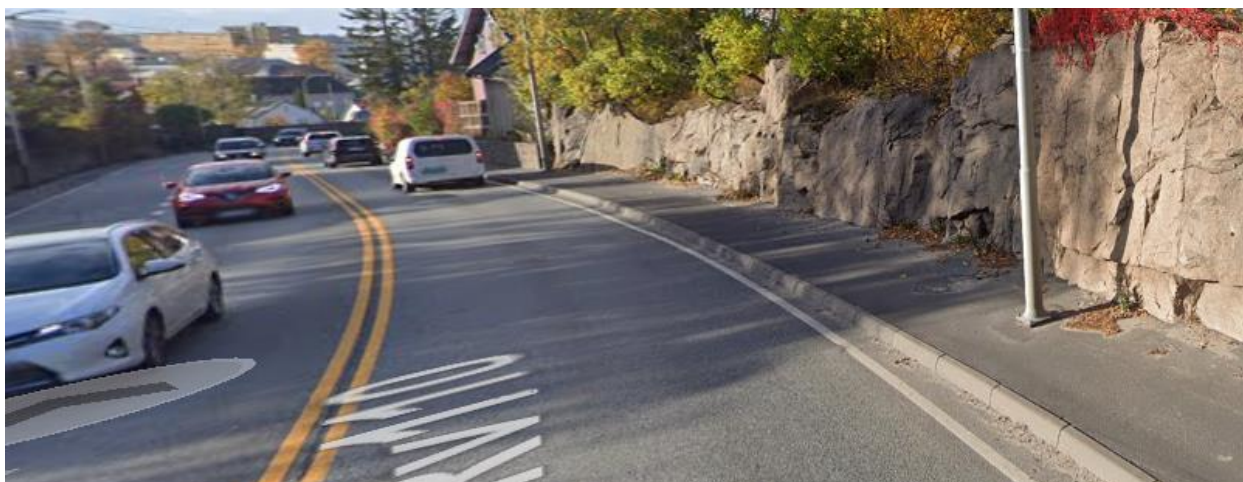
Eksisterende situasjon langs rv.110
