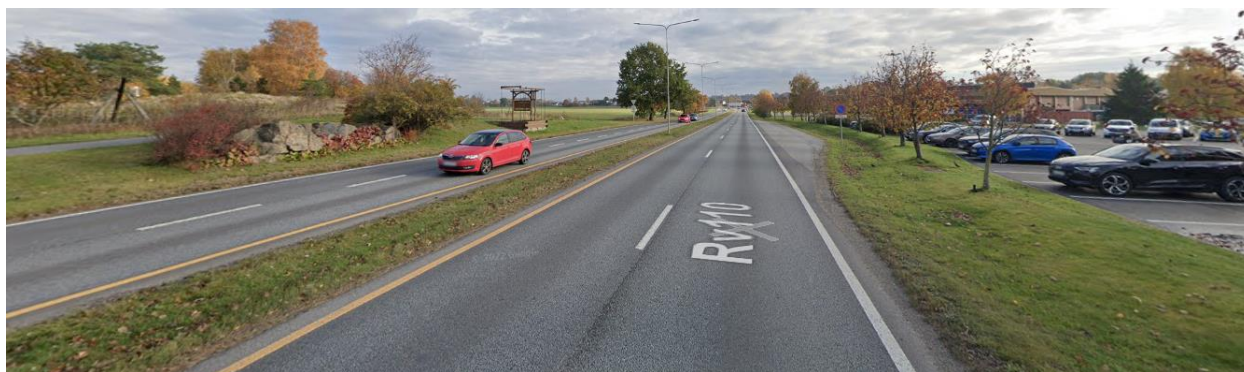
Eksisterende situasjon langs rv.110
